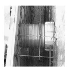
5. Nach dem Ausschalen ergibt sich eine saubere Wandöffnung. Durch den sofortigen Einbau der Rohrdurchführung in die Schalung können Außenwände in einem Arbeitsgang fertiggestellt werden.
