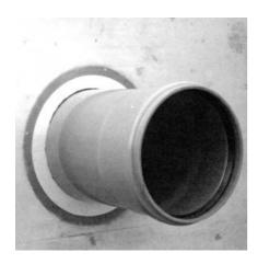
9. Fertige Wand aus Sichtbeton mit einbetonierter Rohrdurchführung und durchgeführtem Kanalrohr, sichtbar auch der Verschmutzungsschutz.
