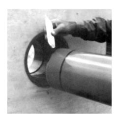
7. Schieben Sie nun das Kanalrohr mit leichter Drehung in die Rohrdurchführung ein.
