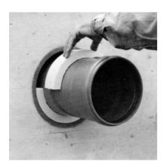
8. Die mitgelieferten Schutz-Halbschalen legen Sie als Verschmutzungsschutz zwischen Rohrdurchführung und Kanalrohr ein.
