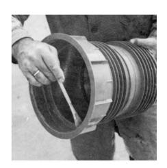
4. Ein bereits vorbereitetes PVC-Kanalrohr der nächstgrößeren Dimension, bei 40 cm Wandstärke beträgt die Rohrlänge 16 cm, schieben Sie sofort nach Auftragen des Klebers in den Verlängerungsteil ein und entfernen die Klebstoffreste!
